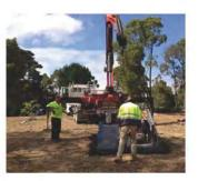
BUNKER BEING CRANED INTO POSITION RADY FOR INSTALL
